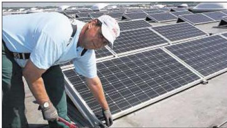
AUF DEM DACH: Günter Mosebach installiert noch den Blitzschutz auf dem Motexdach, das jetzt Photovoltaikanlagen trägt.
